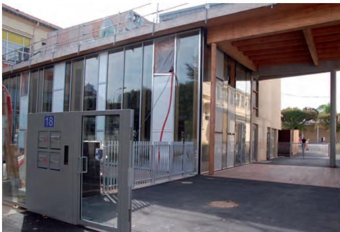
→ L'école République en travaux, façade côté bd Carnot.
