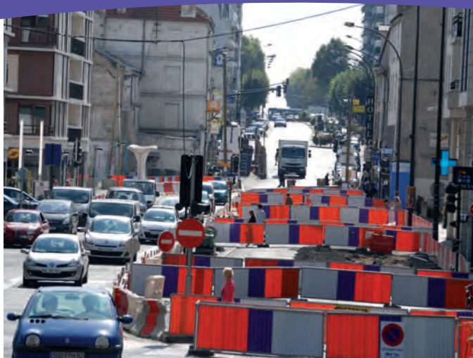
→ Travaux de réfection des réseaux sur l'ensemble de la ZAC de la Bièvre.
