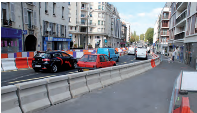
→ Travaux de la RD 920 sur l'avenue du Général-Leclerc.
